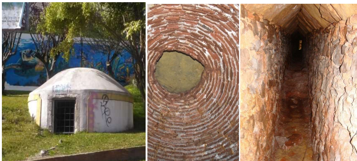
Figura 5.3 - 1 – Exterior da Mina Casal Ventoso, Figura 2 – Cobertura da nascente, Figura 3 – Ducto de Ligação à Nascente -Fonte: C.M.Odivelas
